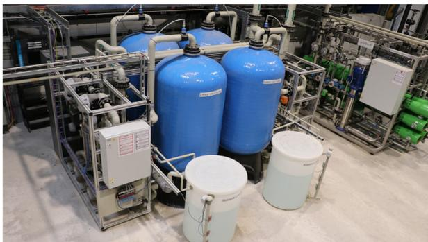
**Abbildung 2:** Nachdem das Rohwasser einen EingangsfILTER passiert hat, wird es in den beiden Enthärtungsanlagen GENO-mat GVA-GK 10/15-2 von Calcium- und Magnesiumionen befreit. Als Doppelenthärtungsanlagen liefern diese rund um die Uhr enthärtetes Wasser – auch während der Regeneration. Bild: Grünbeck Wasseraufbereitung GmbH / Trevira GmbH
