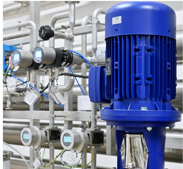
*Die Hochdruckpumpen der Umkehrosmoseanlagen erfüllen die Anforderungen der Energieeffizienzklasse IE5 und können für einen optimalen Betrieb bei unterschiedlichen Betriebspunkten der Anlage ausgelegt werden.*
