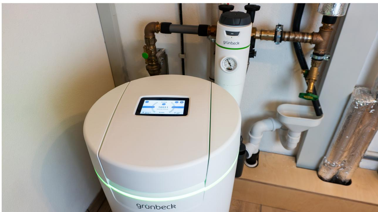
Wo bei Familie Gutmair vorher nur ein Grünbeck-BOXER-Filter verbaut war, befindet sich jetzt das cliQlock-Modulsystem samt Enthärtungsanlage und Filter mit Druckminderer. Bild: Grünbeck AG
