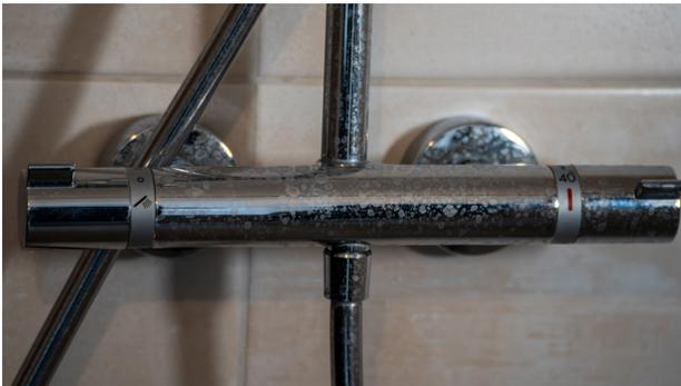
*Kalk setzt sich nicht nur an sichtbaren Bereichen wie Armaturen oder Duschwänden fest. Auch in Wasserleitungen, Waschmaschinen, Spülmaschinen etc. kann er zum Problem werden. Bild: Grünbeck AG*
